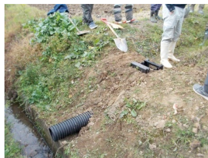
設置方法の説明会で現場に 設置した排水調整器具の状況
