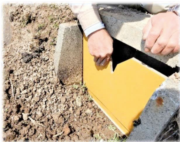
■コンクリート製の排水マス
