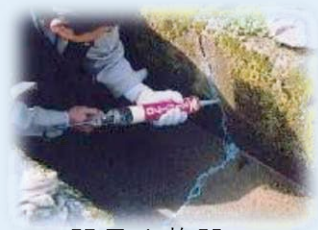
器具や施設の 軽微な補修
