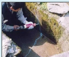
ひび割れの補修
