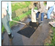
農道の部分補修
