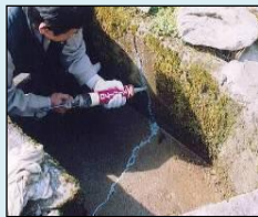
ひび割れの補修
