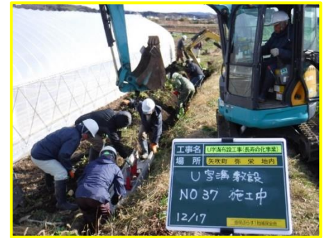
長寿命化活動 水路の更新
