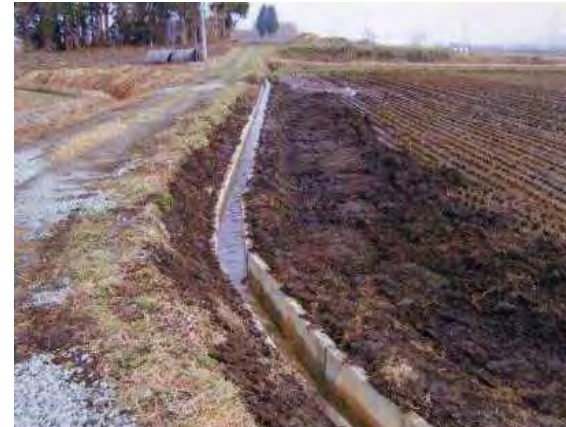
法面を整形して完成。
