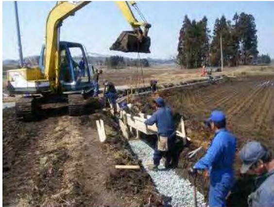
基礎砕石の上にフリュームを設置。
