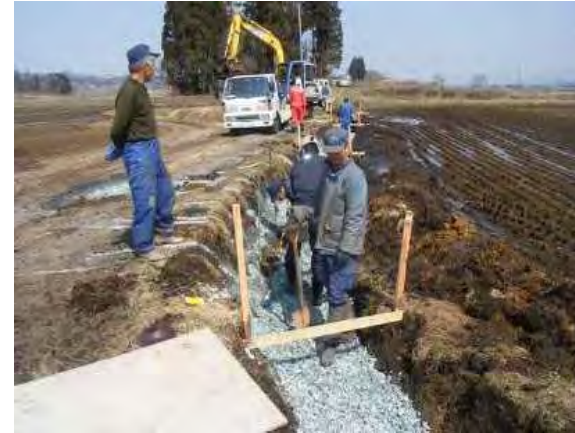
フリューム等設置に必要なとなる基礎砕石の施工。
