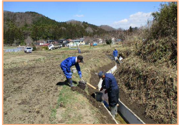
水路の敷設工事
