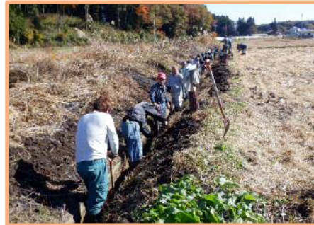
整備した水路の泥上げ作業
