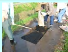
農道の部分補修
