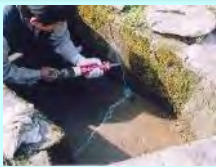
水路のひび割れ補修
