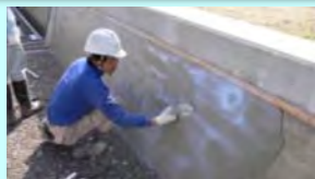
老朽化した水路壁のコーティング
