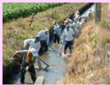
水路の泥上げ
