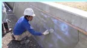
老朽化した水路壁のコーティング
