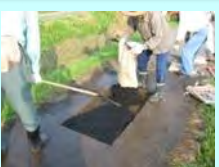
農道の部分補修
