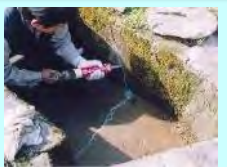
水路のひび割れ補修
