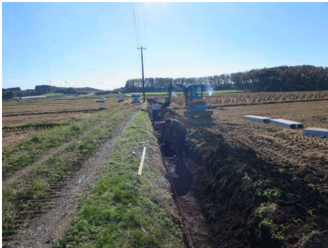
直営施工による水路の敷設作業
