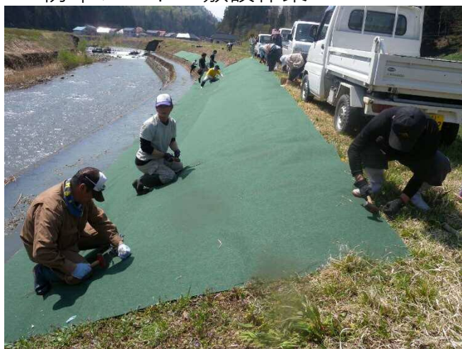
防草シートの敷設作業
