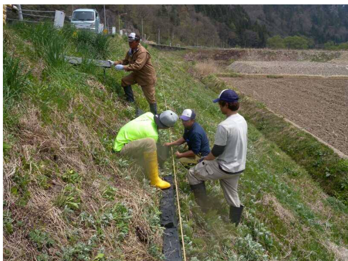
法面の足場設置作業
