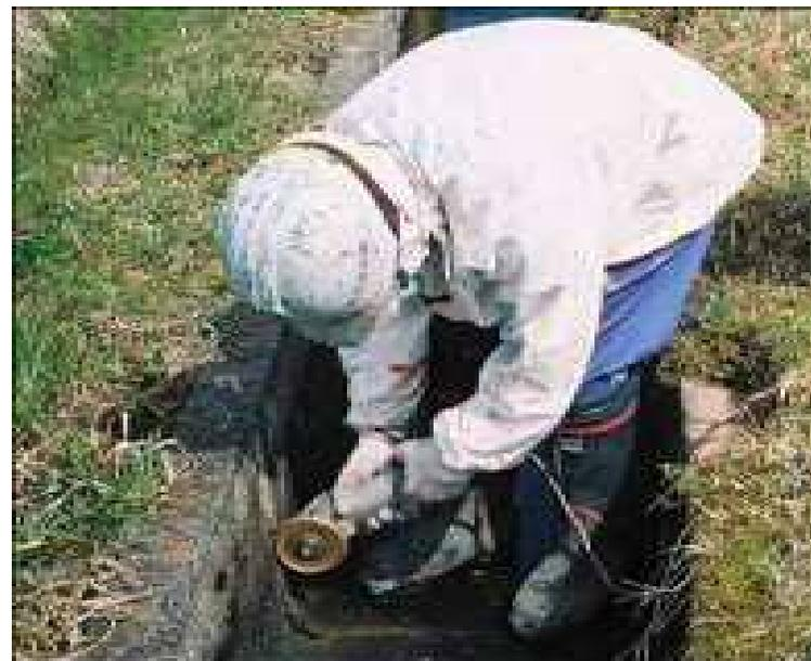
使用するもの: デスクグラインダー(刃はコンクリート用)、タガネ、ハンマー、発電機、コードリール、防護用ゴーグル、マスク
