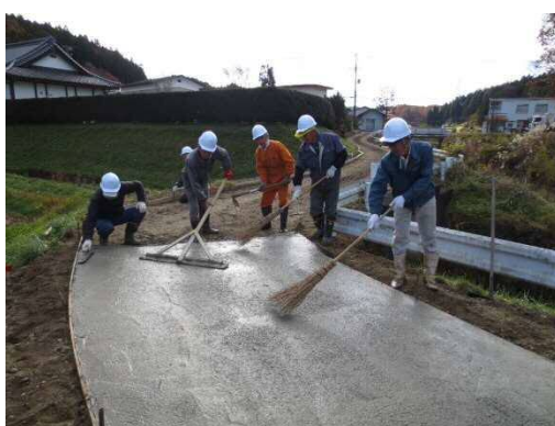
農道舗装工事
