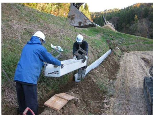
水路補修工事
