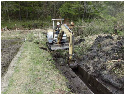
水路の土砂撤去
