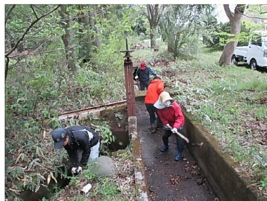
水路の維持管理
