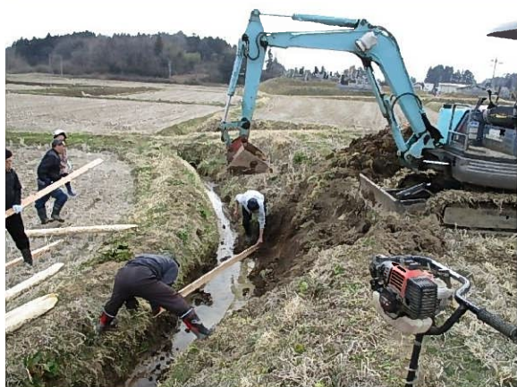
農地の法面補修
