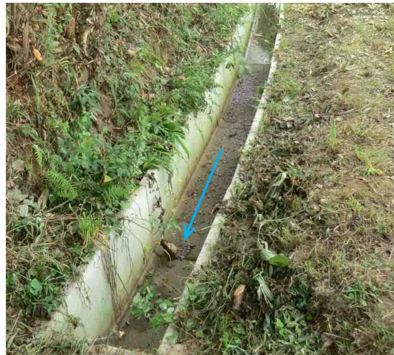
用水路は必要水量を漏水することなく送水させる必要があるが、目地から漏水してしまう。水が足りなくなる。また、法の崩壊も懸念される。用水路については目地詰めする。
