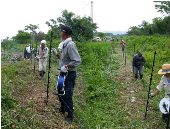
5段の電気柵を3年間で総延長3.7km設置した
