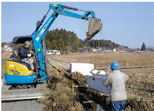
地域直営で行う水路の敷設
