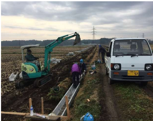
長寿命化の活動で、水路工事の直営施工をしています
