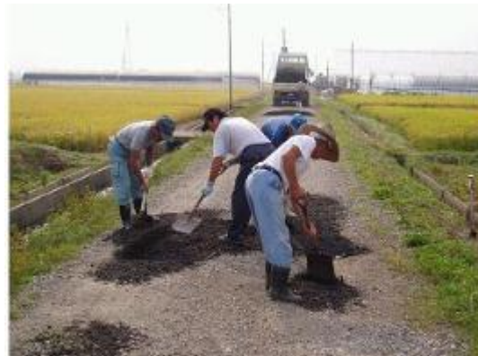
共同作業による砂利の敷き均し
