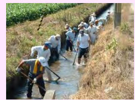
水路の泥上げ
