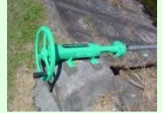
ゲート、バルブの更新
