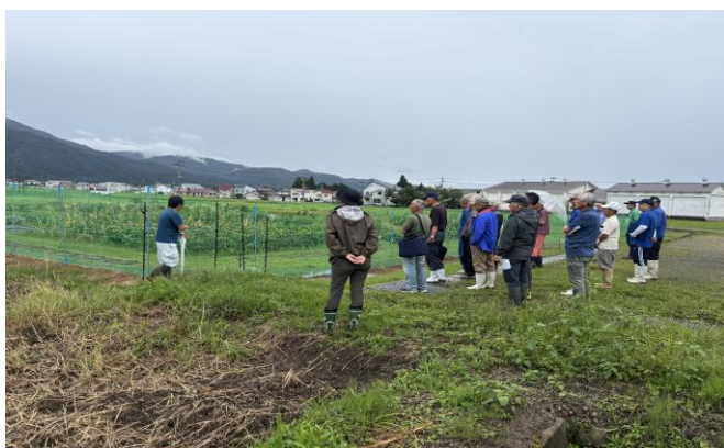
電気柵設置の技能研修
