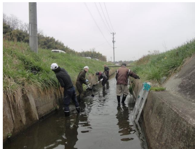
水路の泥上げ作業
