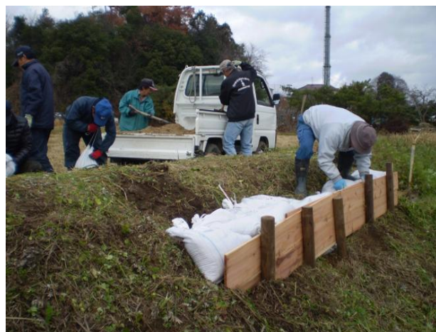
法面の安定化にむけた土のう設置
