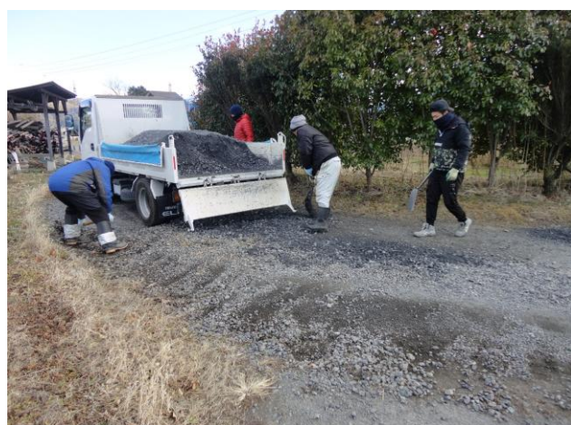
農道への砂利 敷き作業
